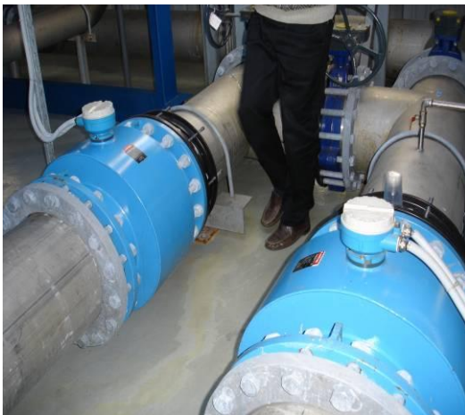
Kuva 3.2 Verkostoon pumpattavan vesimäärän mittaus pysyvillä ja tilapäisillä mittareilla (Pilcher 2004)
