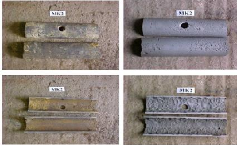
Kuva 4.7 Suurimpien vuotokohtien materiaali tunnistetaan, arvioidaan ja tiedot tallennetaan (Source, Halcrow Group 2007)
