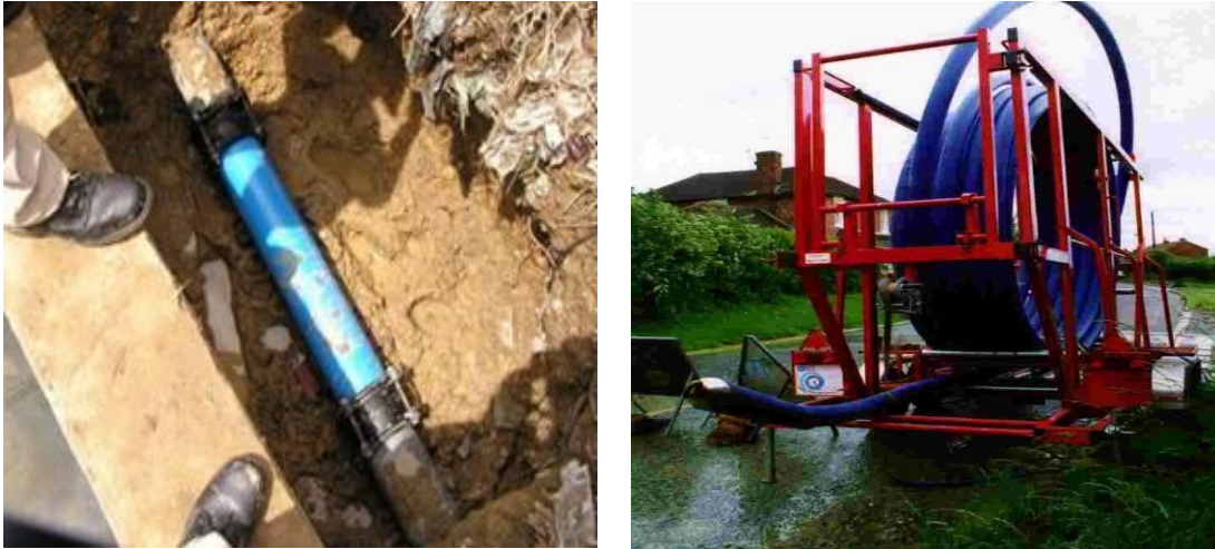
Kuva 4.6 Korjaus tai saneeraus (Source, Halcrow Group 2004)
