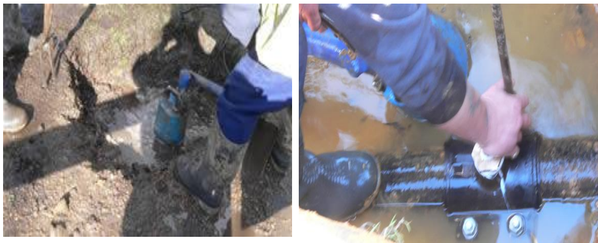
Kuva 7.4 Putken korjausta (Mid Kent Water Company 2007)
