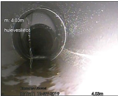
110 mm muovi, liittymä, tonttviemäriin liittyy tonttihulevesiviemäri klo 11
