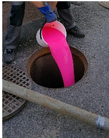
Kuva 30. Esimerkkejä väriainekokeen tekemisestä.
