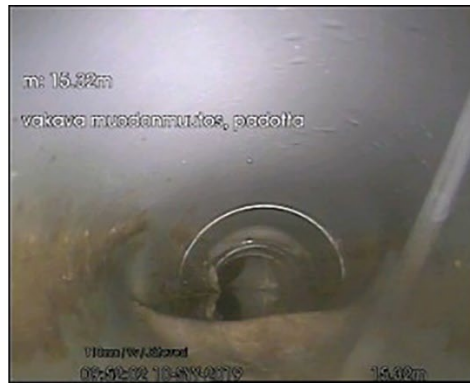
110 mm muovi, vakava muodonmuutos, pistemäinen klo 5–7
