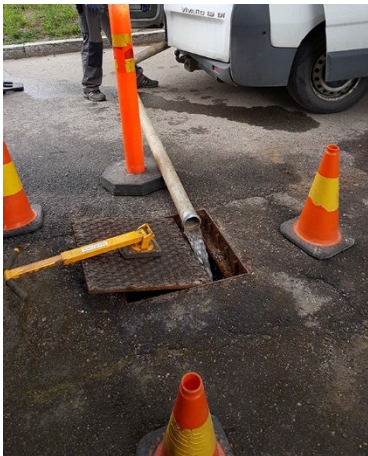
Kuva 30. Esimerkkejä väriainekokeen tekemisestä.
