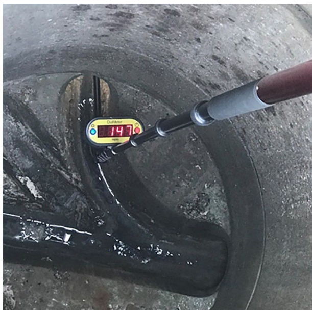
Kuva: SewCon Kuikka Oy
